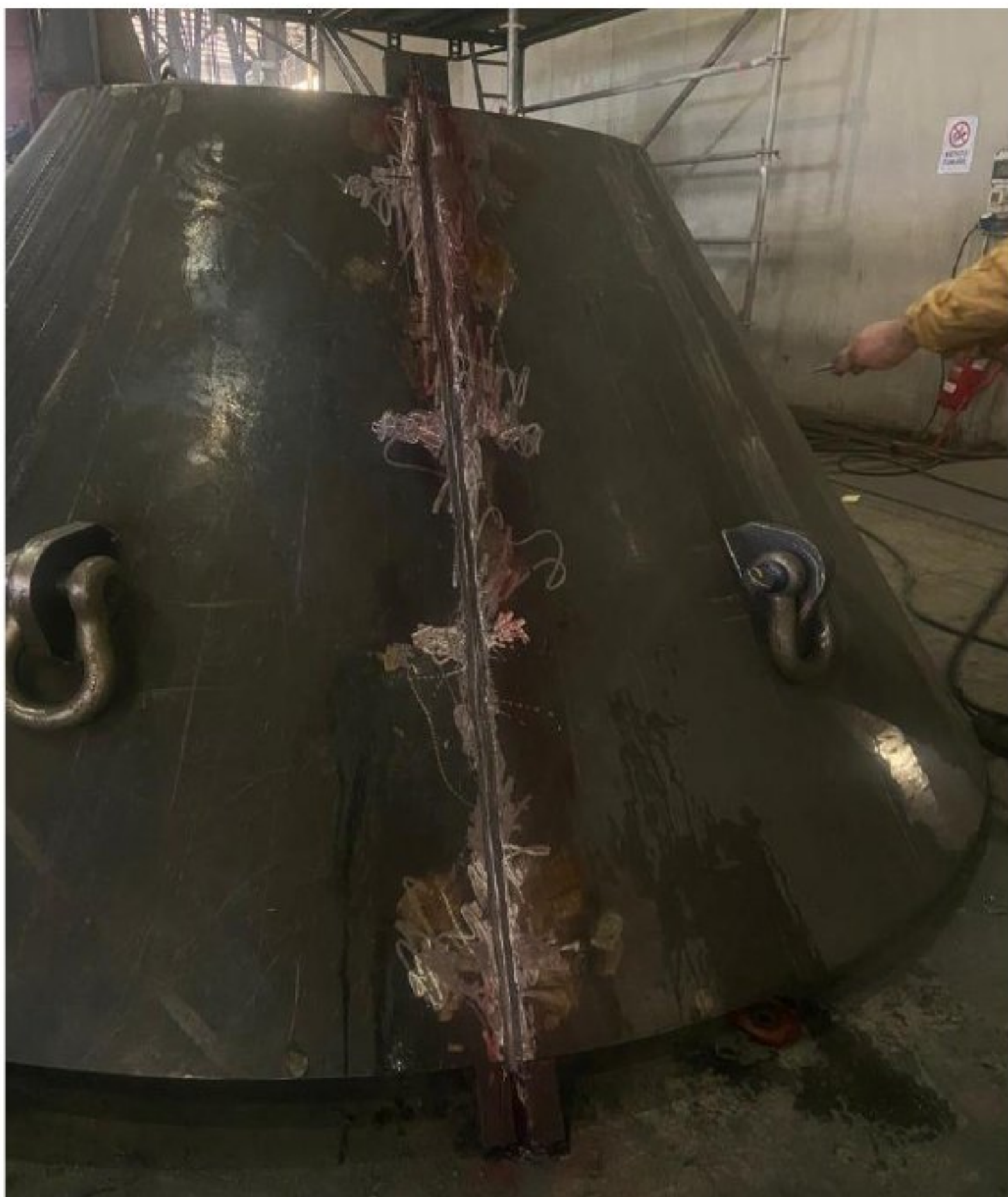
1)Završetak čišćenja vara (provvara)
