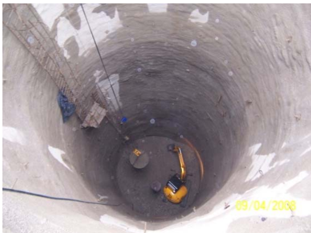
a. Izgradnja okna, otkopavanje bagerom
