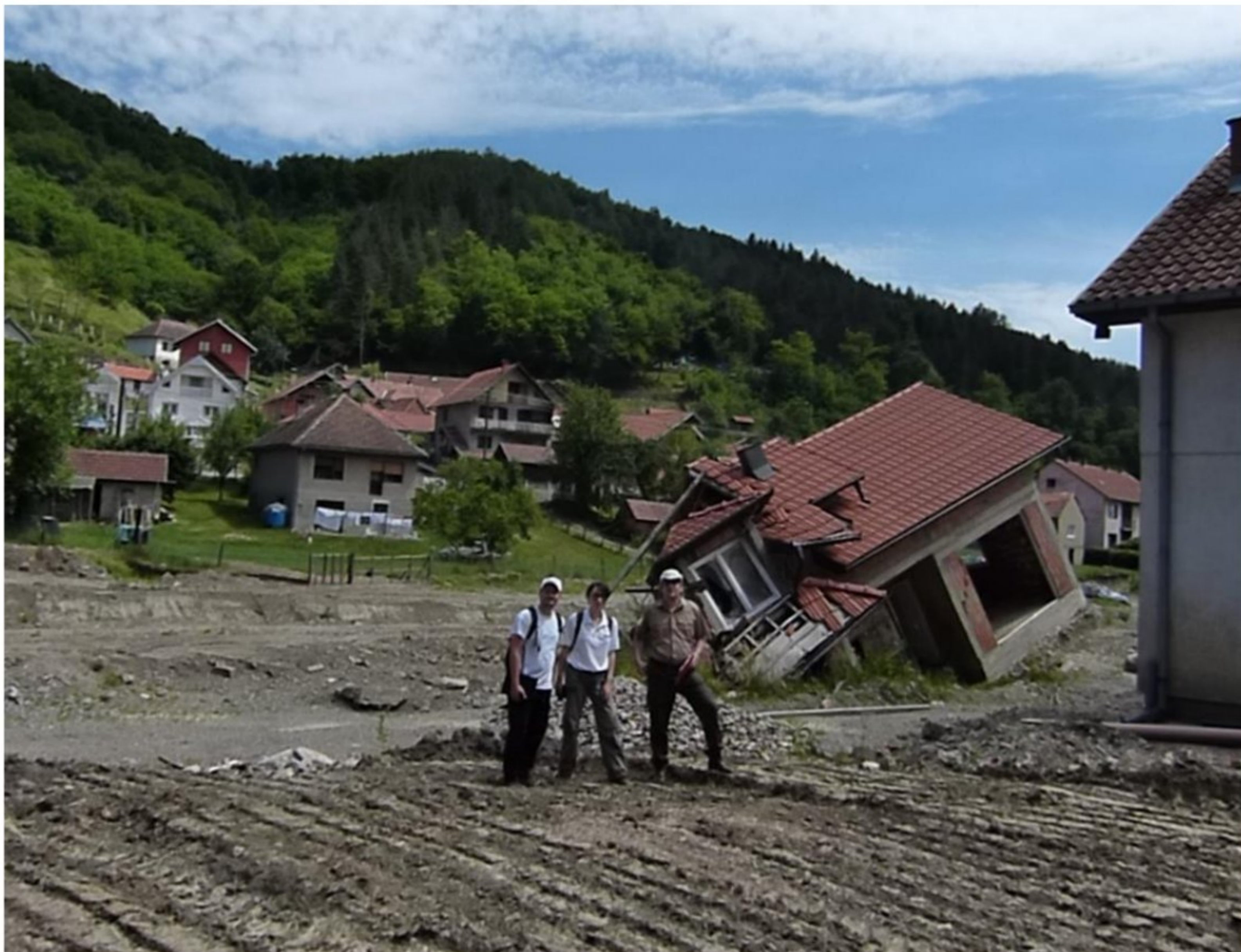
Слика 3.1 Порушени објекти на подручју Крупња као посљедица масовних појава нестабилности (фото Аболмасов, 2015)
