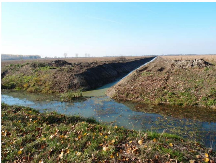
Слика 4.3.15: Очишћени дренажни канали у зони бунара Вр-24 и уливање латералног канала у главни дренажни канал I линије (фото: Мајкић 2012)
