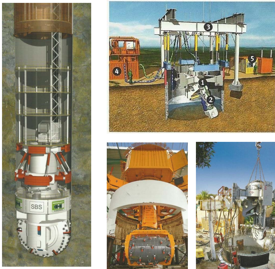
Slika 4-6, Ilustracije izrade okna VSM tehnologijom
