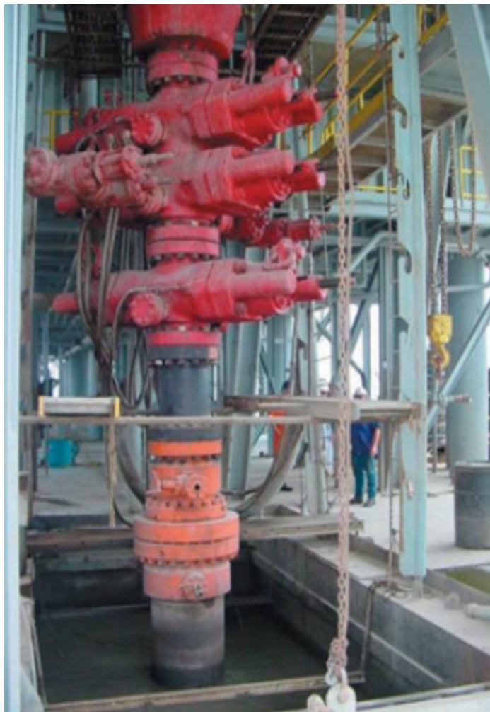
Slika 3.8.1- Preventerski sklop BOP (izvor: Matanović D., 2007 „Tehnika izrade bušotine priručnik s primjerima“, Zagreb)
