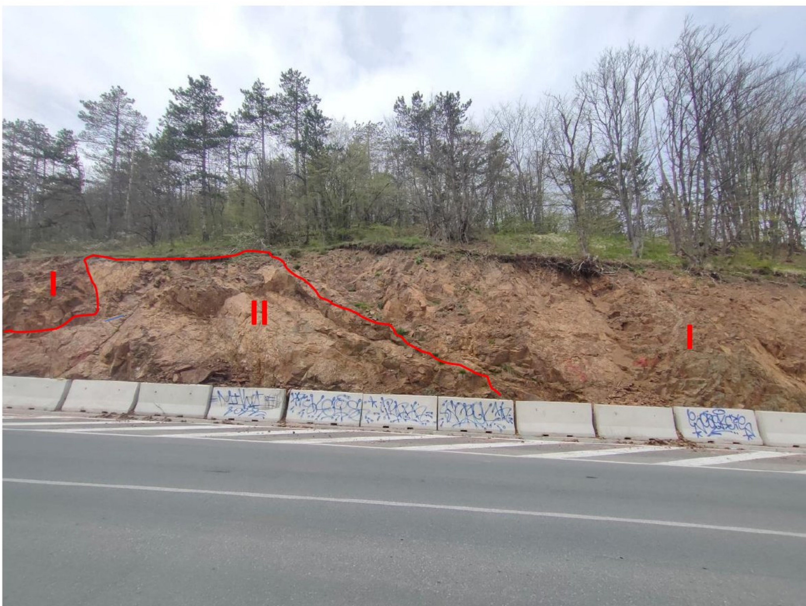
Slika 6.3. Kosina sa izdvojenim kvazihomogenim zonama po parametru ispucalosti
