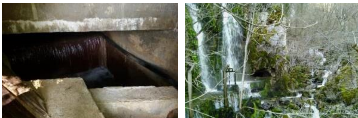
Sl. 6.24. Vrelo Seljašnice – kaptaza donjeg vrela (levo); Isticanje podzemnih voda na gornjem vrelu u maksimumu (desno)
