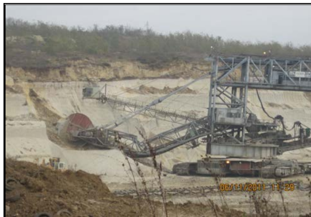
Slika 2.6.- Oštećeni bager (G-3) usled zarušavanja etaže na severnoj kosini kopa Polje D
