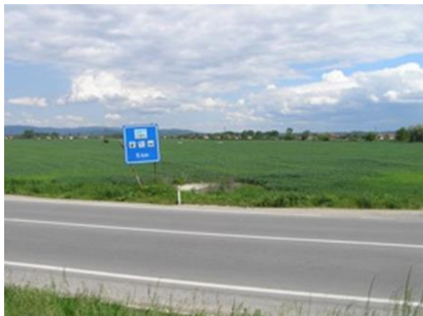
Слика 2.4. Место пролаза потисног цевовода ДН600 испод државног пута IБ реда бр.26 (фото: И.Круљ)
