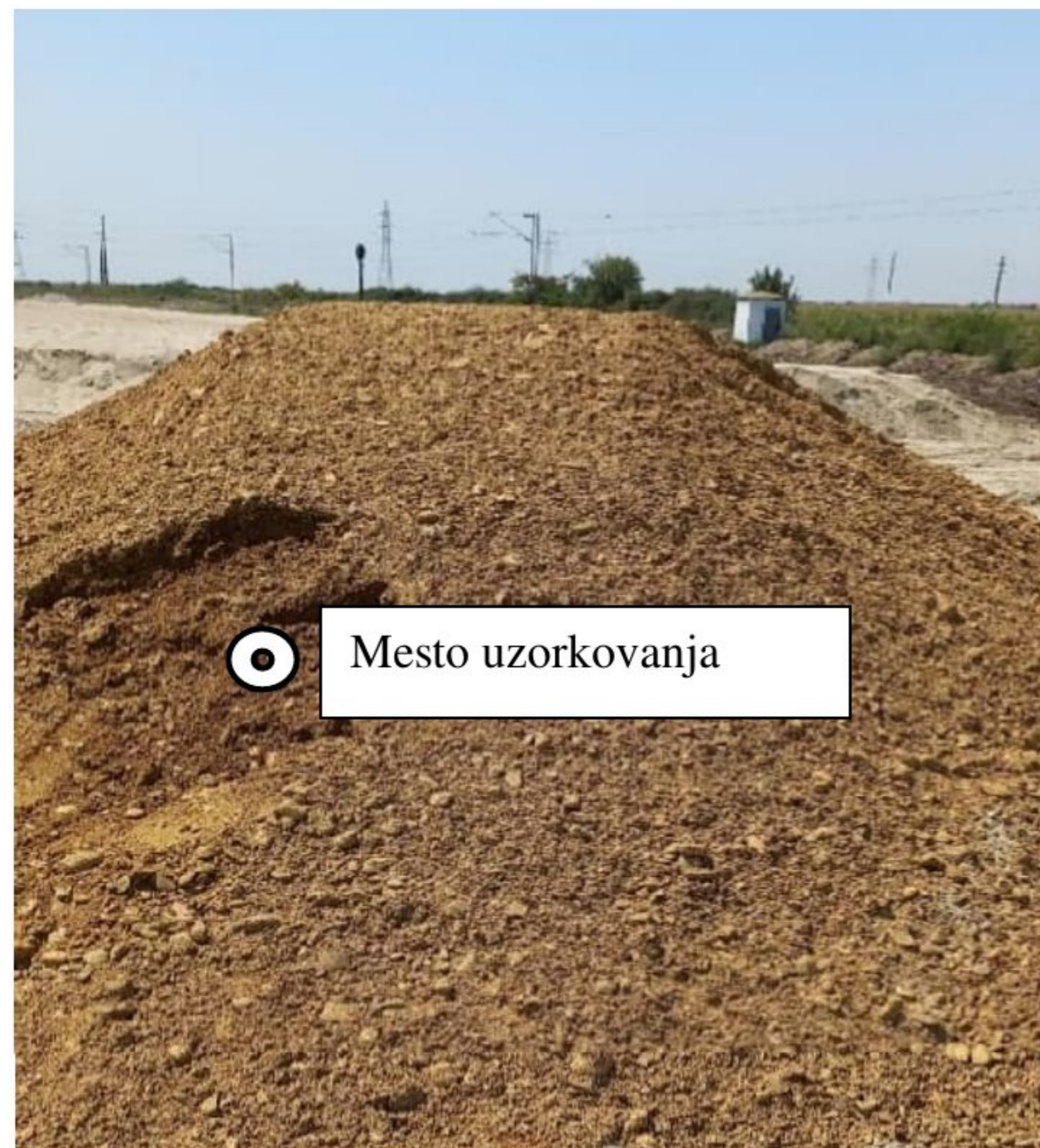
Slika 4.14. Privremena deponija materijala – gradilište Petlja Batajnica (Autoput E75)
