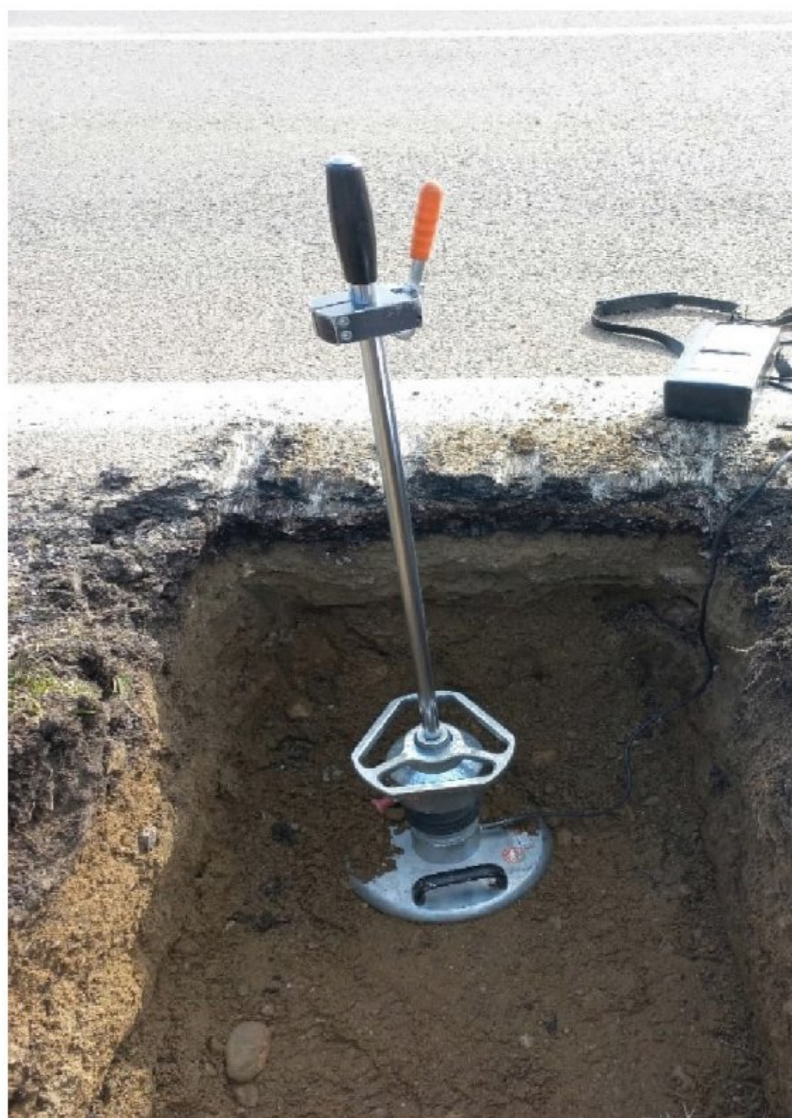
Slika 3.15. Merenje dinamičkog modula deformacije - E_{vd} pomoću uređaja sa padajućim tegom, posteljični sloj na lokaciji objekta Autoput E-80: Niš (Merošina) - Pločnik (Beloljin)
