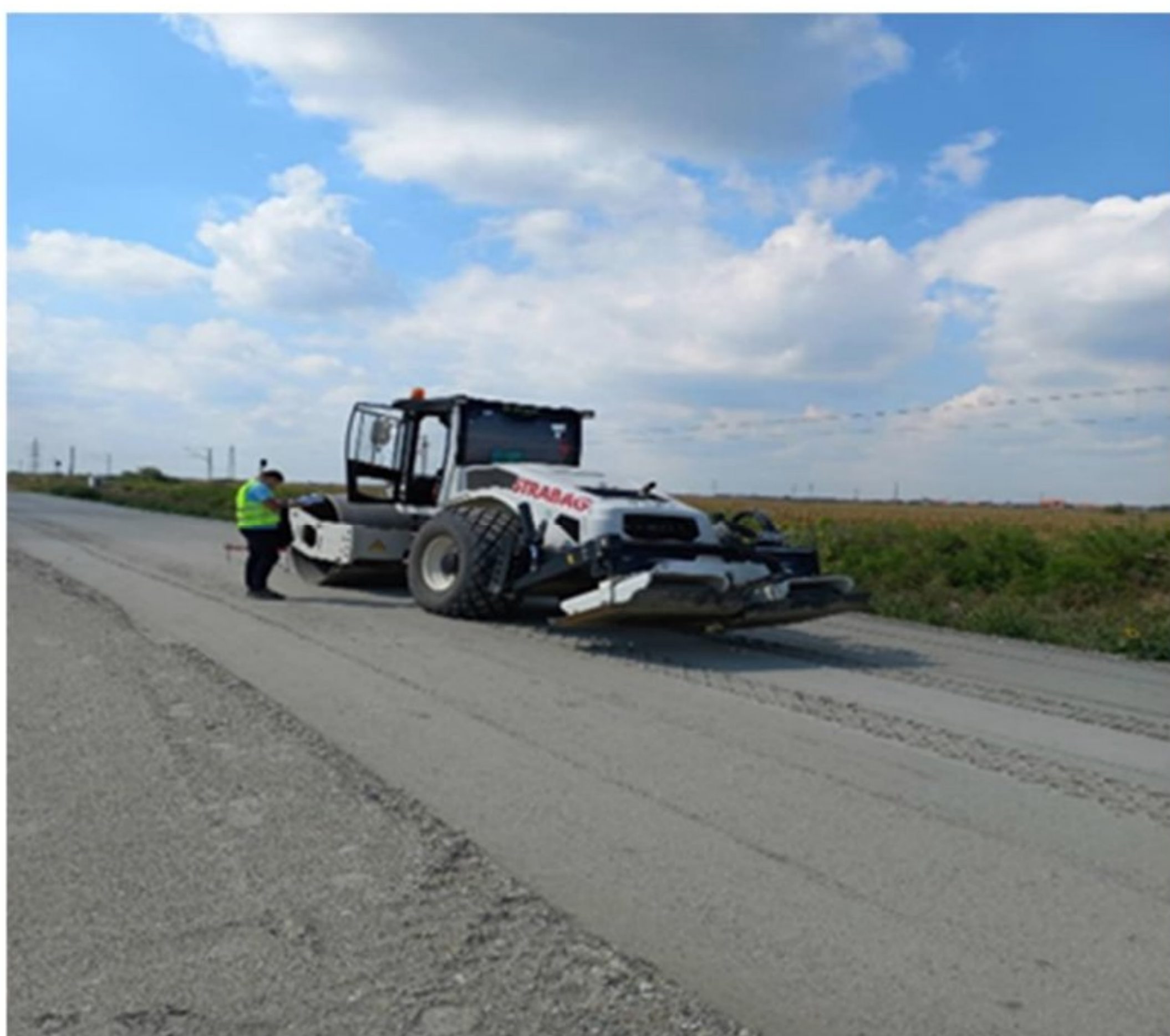
Slika 1.1. Proces zbijanja tokom izgradnje posteljičnog sloja na lokaciji Petlje Batajnica -Autoput E75 u Beogradu (2020)
