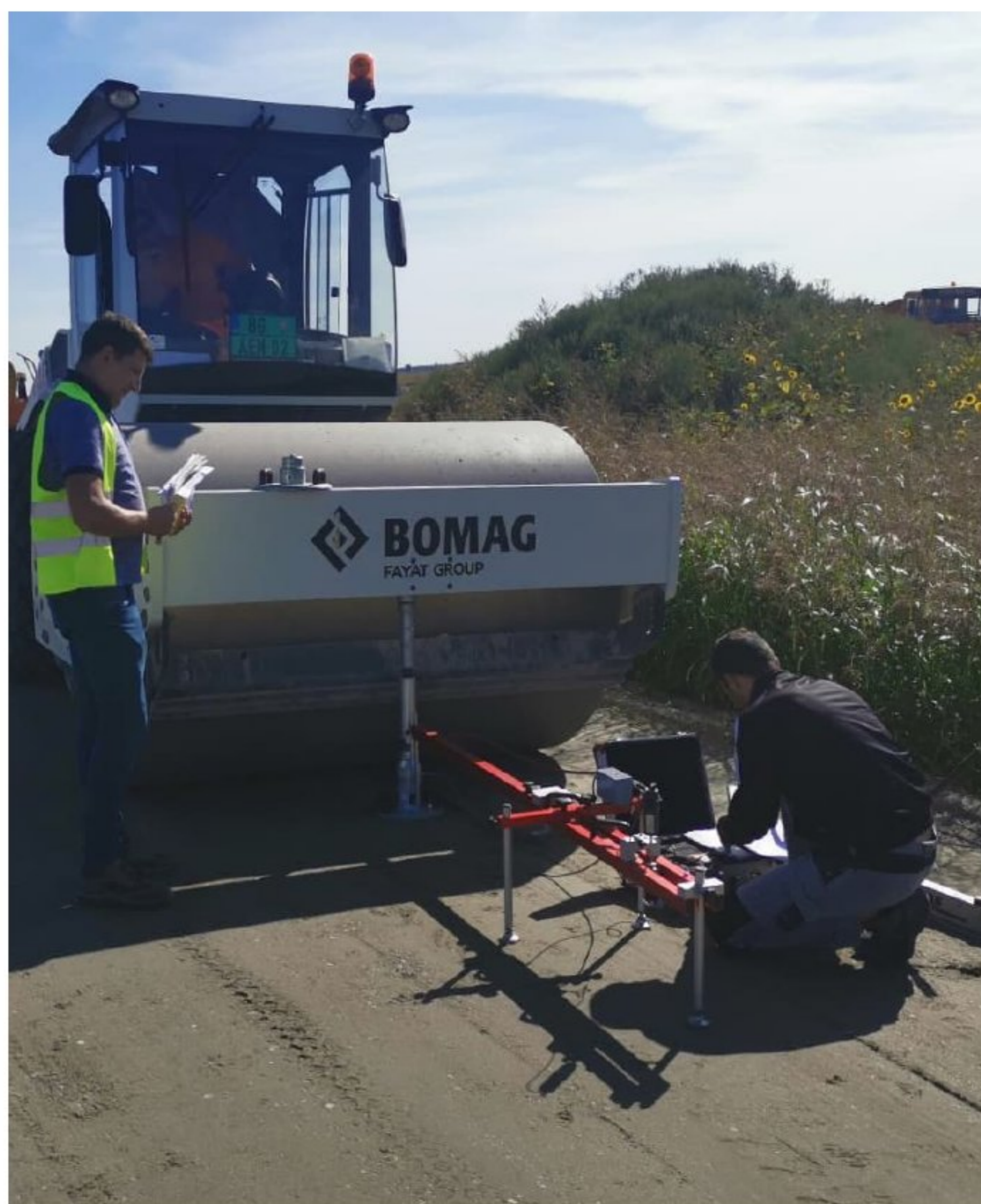
Slika 3.10. Merenje modula deformacije -(E_{v1}-E_{v2}) , sloj nasipa na lokaciji objekta Intermodalni terminal "Batajnica" u Beogradu
